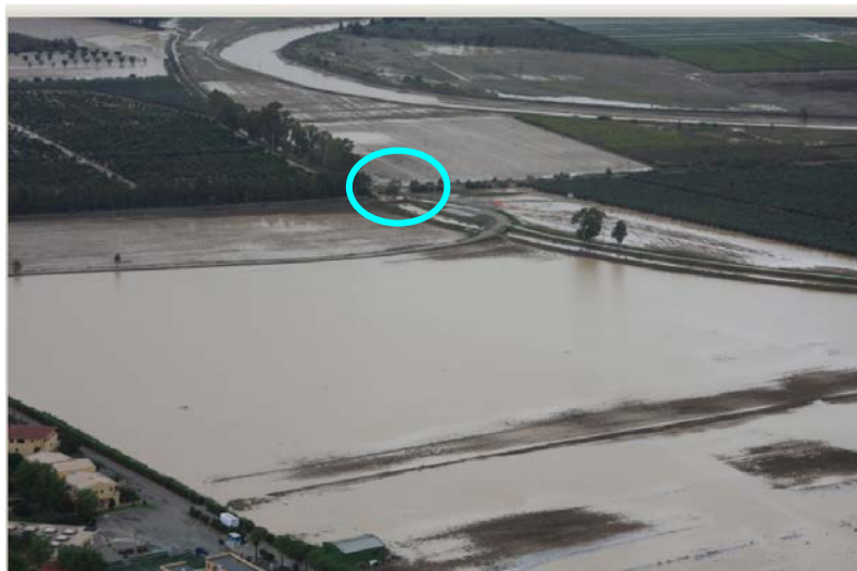
Rottura rilevato arginale in destra fiume Bradano (UoM ITI012) - Allagamento del sottopasso della strada arginale in corrispondenza del rilevato ferroviario e delle aree prospicienti gli insediamenti turistici
