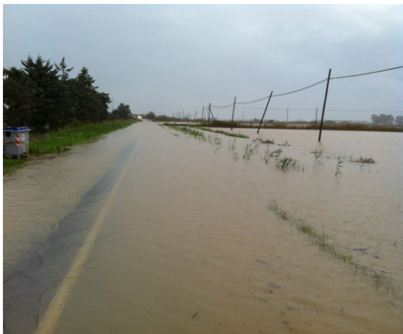
Allagamento della viabilità nell'area di Scanzano Jonico (UoM ITR171) a seguito di esondazione di fossi e canali di bonifica
