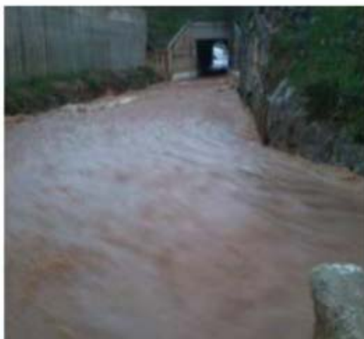
Allagamento tombino a Fasano
